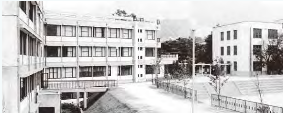
楠ヶ丘学舎のパノラマ写真 左から本部・研究所棟、学舎、部室会館、体育館 学生会館はまだ建設されていない。
