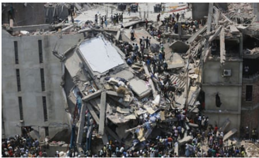
写真 2: 崩壊したラナプラザビル(The Guardian 2015)
