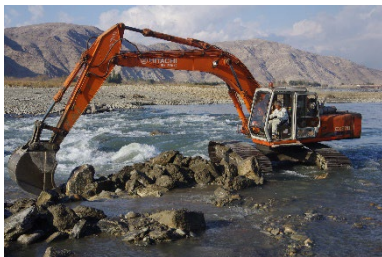
写真4: カマの取水堰改修作業中の中村医師 2011年1月 (提供: PMS(平和医療団・にほん))
