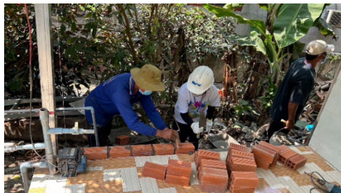
写真 2: 壁の建設の様子 (筆者撮影)
