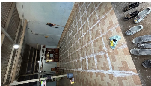
写真 3: 床を敷設する様子 (筆者撮影)
