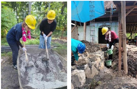
写真4: セメント作業(ハビタット撮影)
