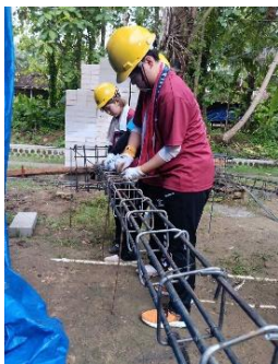
写真3: 柱の組み立て作業(ハビタット撮影)
