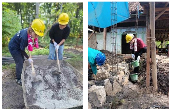
写真4: セメント作業(ハビタット撮影)
