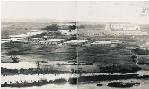
写真 3: ナタールのサウキビ農園と長屋(1860 Heritage Centre, 2024)
