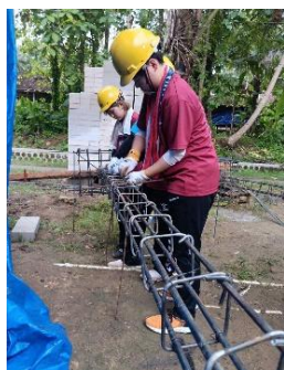
写真3: 柱の組み立て作業(ハビタット撮影)
