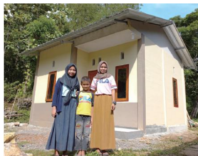
写真5: 完成予定の住居 (Habitat for Humanity Japan, 2022)
